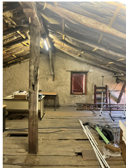
7 - Combles de la mairie
